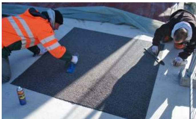
Устройство дренируемого дорожного покрытия в городском ландшафте
