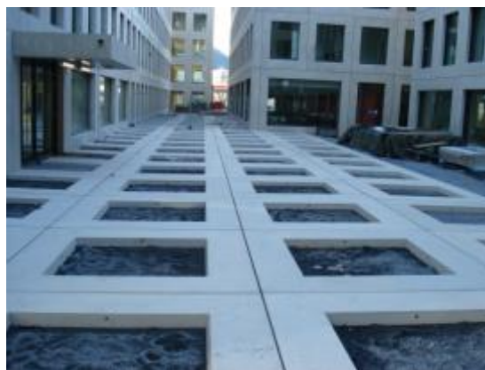
Устройство дренируемого дорожного покрытия в городском ландшафте
