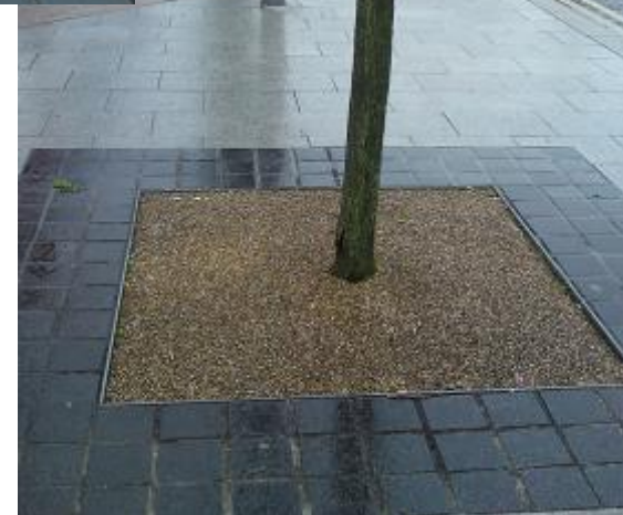
Устройство дренируемого дорожного покрытия в городском ландшафте
